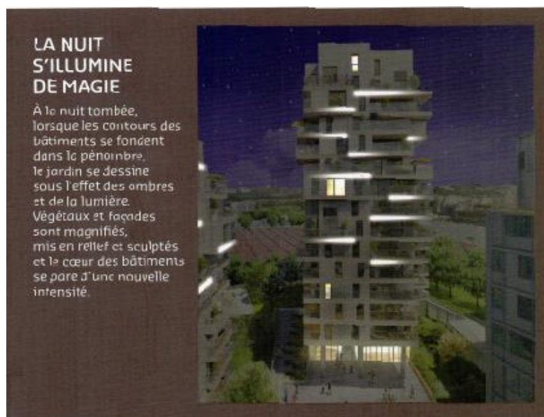
Figure 11 : Illumination nocturne du projet Regards sur la Ville Plaquette Regards sur la Ville, Bouygues Immobilier, date non mentionnée
