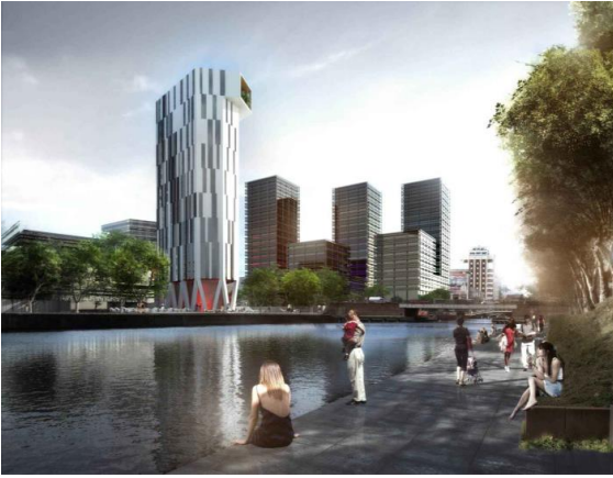
Figure 14 : Projet de la Tour Elithis Danube avec en arrière plan les 3 Black Swans à Strasbourg (Source : http://www.elithis.fr/realisation/tour-elithis-danube/ )
