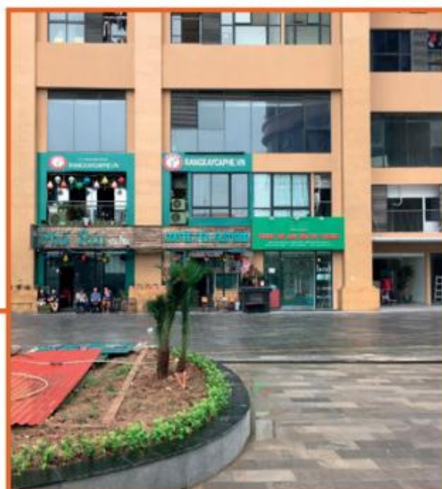
Fig.108 Pied d'une des tours de la seconde phase de l'opération "Goldensilk", où des commerces empruntant à l'organisation du compartiment chinois se sont installés / Photographie de l'auteur
