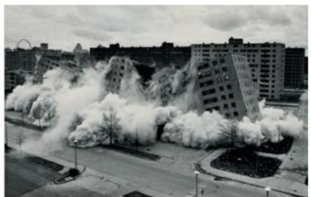
Fig.115 Destruction, en 1972, des grands ensembles du quartier résidentiel de Pruitt Igoe aux USA moins de vingt ans après leur construction, qui signe, selon C. Jenks, la « Mort du modernisme ». / Source : Creating Defensible Space
