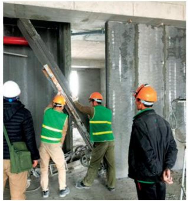
Fig.75 Assemblage de panneaux ACOTEC sur le chantier de la résidence «Xuan Mai Complex» / Source : Elematic
