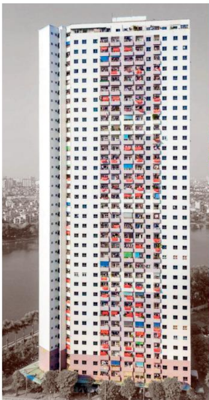
Fig.51 Façade de la tour de logements abordables de l'opération «VP6 Linh Dam», où les occupants manifestent clairement leur mécontentement. Sans parler des modifications en plan, 10 étages de plus ont été construits par rapport à la planification / Source : Baomoi
