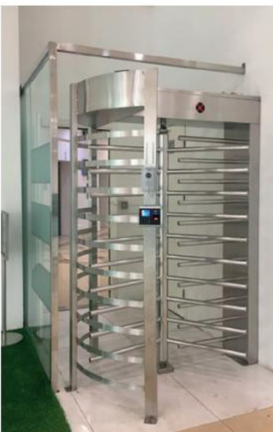
Fig.96 Portique de contrôle à l'intérieur du hall pour accéder aux ascenseurs desservant les logements d'une des tours de la résidence de haut standing «Royal City». / Photographie de l'auteur
