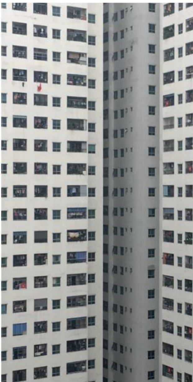
Fig.66 -Boîte percée, zoom sur la façade de l'opération de logements abordables «HH Linh Dam». / Photographie de l'auteur
