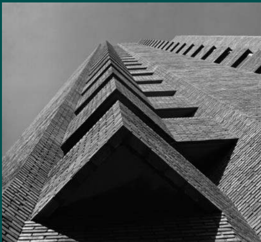
EXCEPTIONAL PLACEMENTS - CATALINAS NORTE - EDIFICIO CONURBAN – 1969 ARQ. ESTANISLAO KOCOUREK - ERNESTO D. KATZENSTEIN - C. LLORENS
